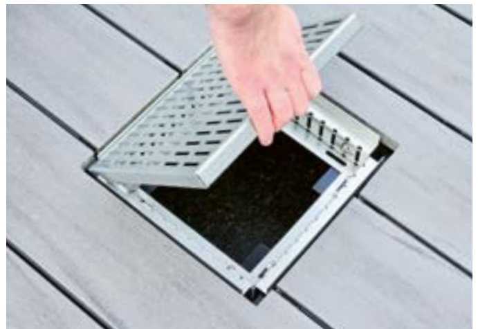
Abdeckblech in den montierten Kasten einlegen.
