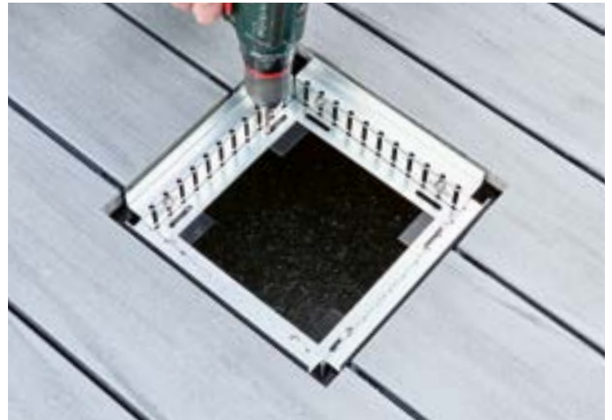
Revisionskasten einsetzen und an Windlastträger verschrauben.
