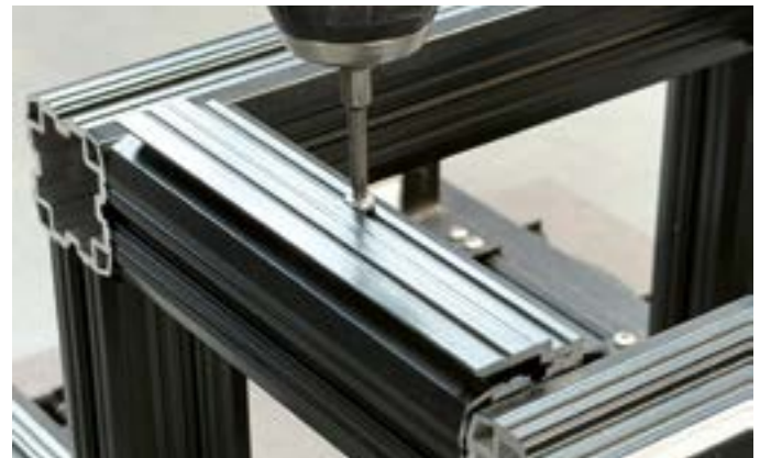
Z-Profil auf der Aluminium-Unterkonstruktion positionieren und befestigen.
