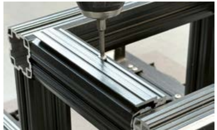
Z-Profil auf der Aluminium-Unterkonstruktion positionieren und befestigen.
