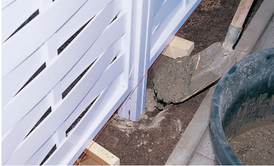
Zaunpfosten direkt ins Erdreich einbetonieren...
