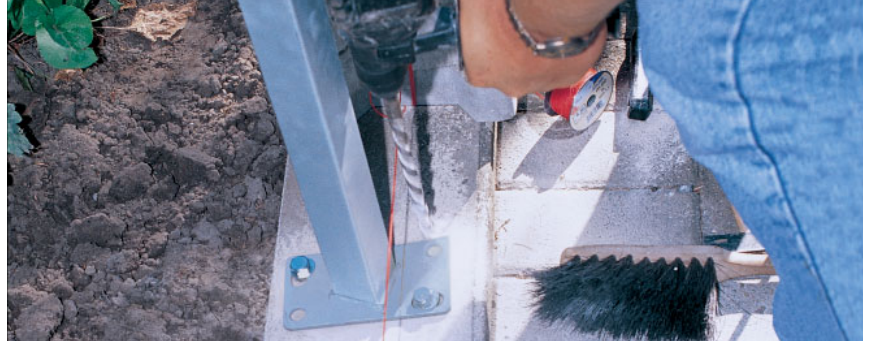
oder mit Pfostenträger aufschrauben.
